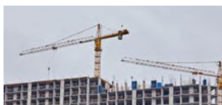
SUR UN CHANTIER DE CONSTRUCTION
